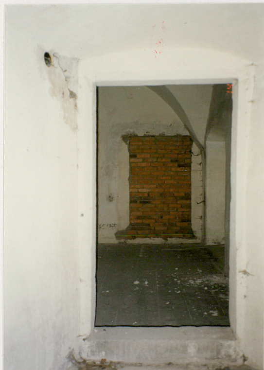
Wejście do izby na półpiętrze zatynkowany portal piaskowcowy
