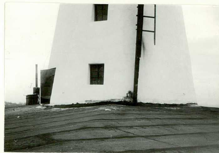
8. Trzon na wysokości dachu bud. mieszk-przemysłowego młyna. Dach - pomost dla obsługi skrzydła.
