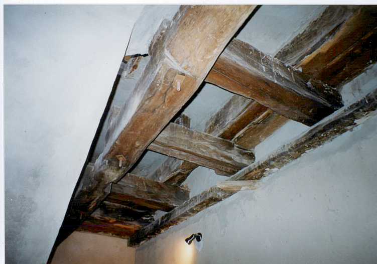
Drewniana konstrukcja muru szachulcowego
