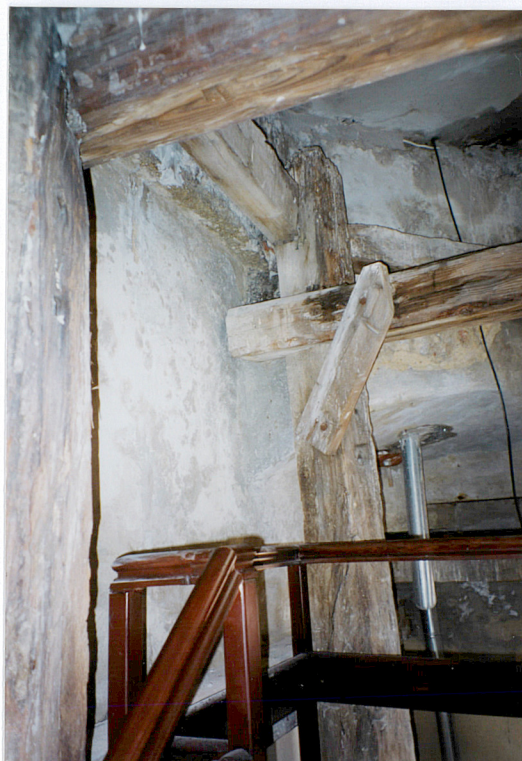
Drewniana konstrukcja muru szachulcowego
