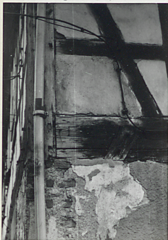
Połączenie kondygnacji
