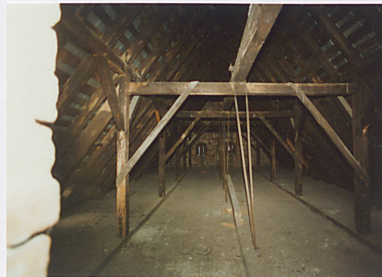
15. Więźba dachowa nad nawą.
