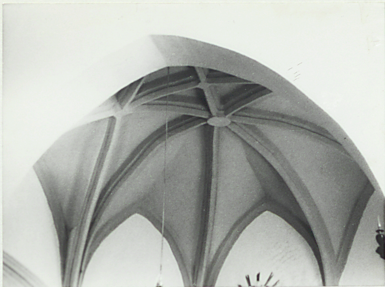
5. Sklepienie sieciowe w prezbiterium oraz fragment łuku tęczowego
