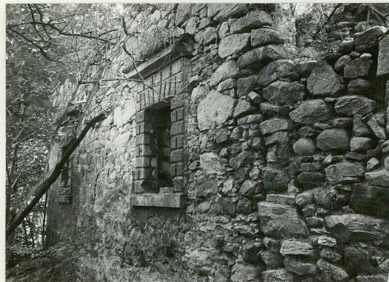
Boniowane obramienia okien w elew. pn.
