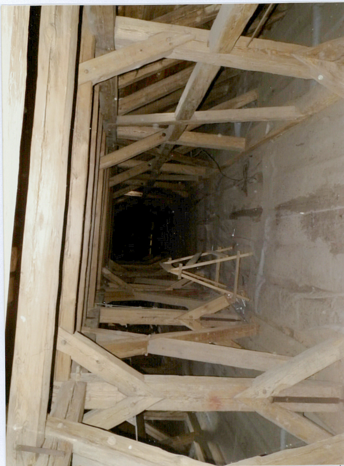
fot. 23. Konstrukcja więźby dachowej nawy.
