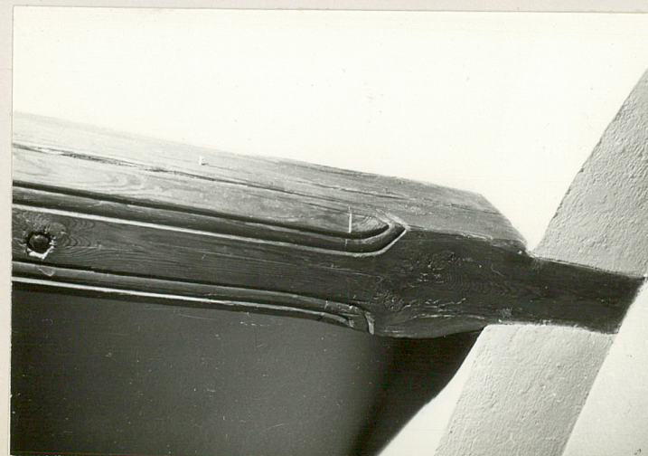
fot.7 profilowany podciąg drewniany w pomieszcz. pñ. 1.piętra
