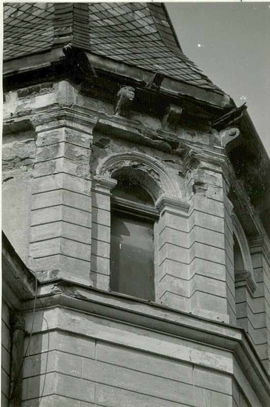
Ost. kond. wieży; zniszczony gzyms od strony pd.
