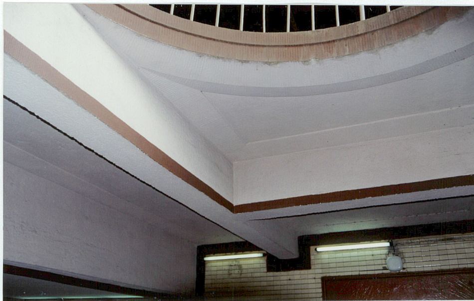
6. Żelbetowe podciągi przy otworze wejścia na peron, neg. 1500/603/5
