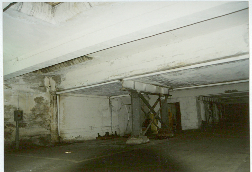
5. Żelbetowe podciągi stropu i konstrukcja stalowa podpór pośrednich, neg. 1500/850/2
