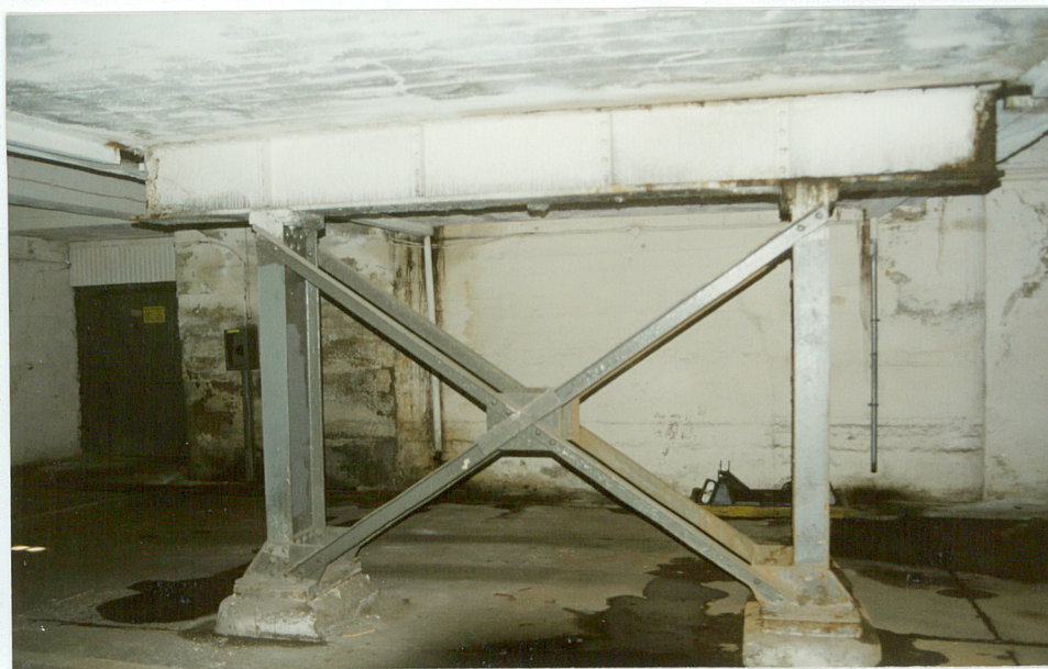
4-7. Konstrukcja podpór pośrednich i ściana wydzielająca schron przeciwlodniczy, neg. 1500/848,4, 1500/850/6, 1500/851/2 i 4
