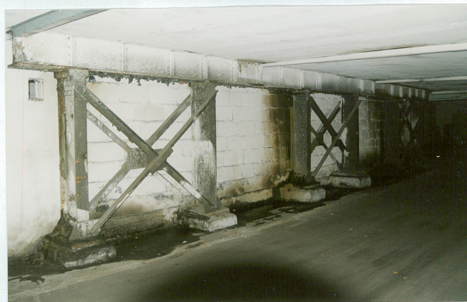
4-7. Konstrukcja podpór pośrednich i ściana wydzielająca schron przeciwlodniczy, neg. 1500/848,4, 1500/850/6, 1500/851/2 i 4
