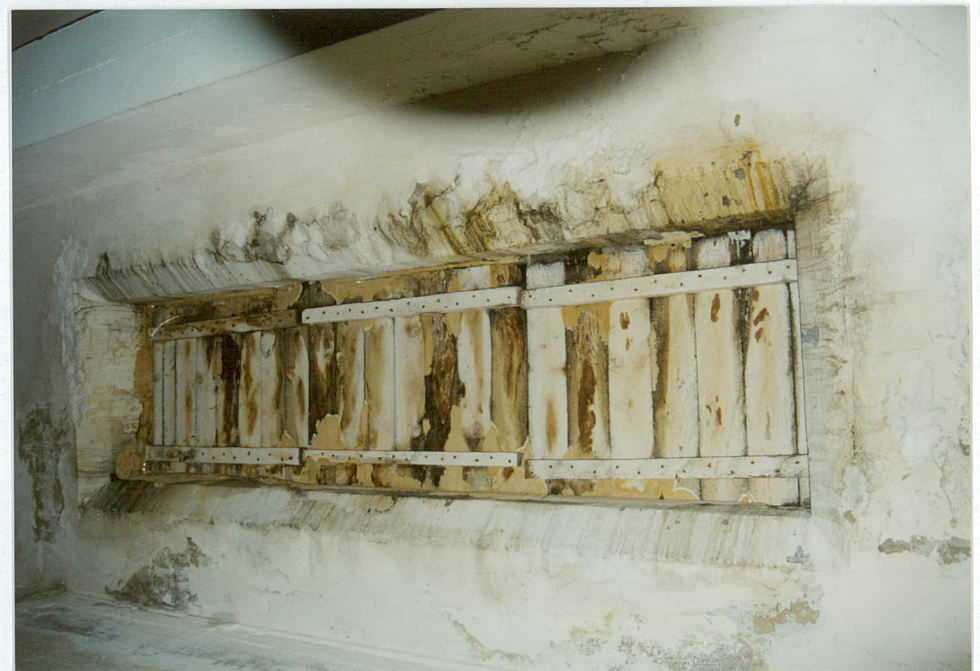
7. Zabity deskami świetlik doświetlający tunel, neg. 1500/850/5
