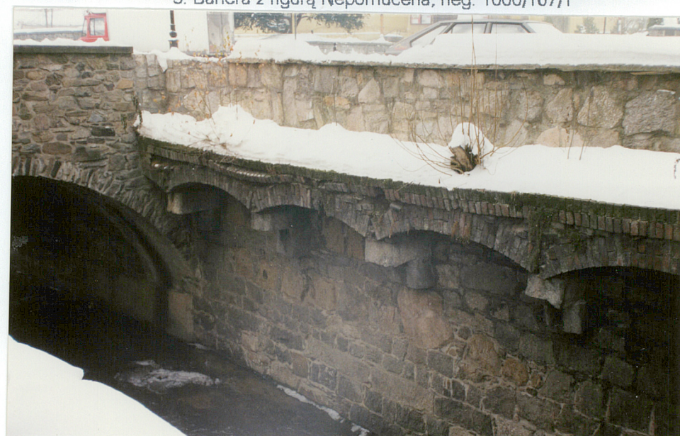
7. Łęki wsparte na konsolach w murze oporowym - element wzmocnienia muru oporowego w szczycie nieistniejącego bud., neg. 1000/169/3
