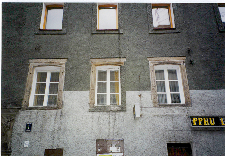
Elewacja zach. otwory okienne w kamiennych obramieniach
