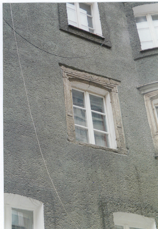
Elewacja pln., kamienne nadproże i obramienie okna
