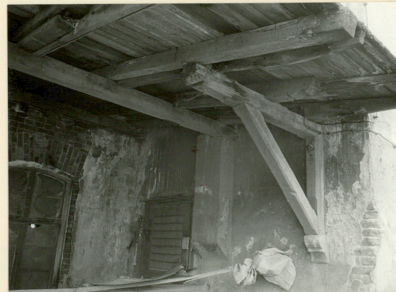
Konstrukcja daszku nad 1 kond.
