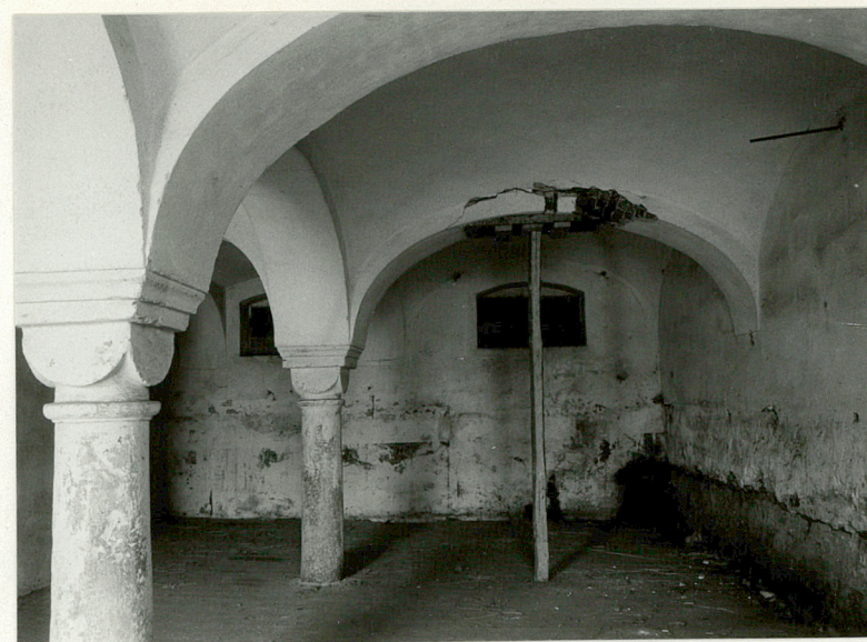
Sklepienie wnętrza obory z pękającym i prowizorycznie podpartym sklepieniem.
