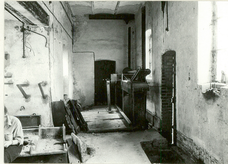
Siłownia, przejście do tartaku. Urządzenie do spuszczenia stawideł.
