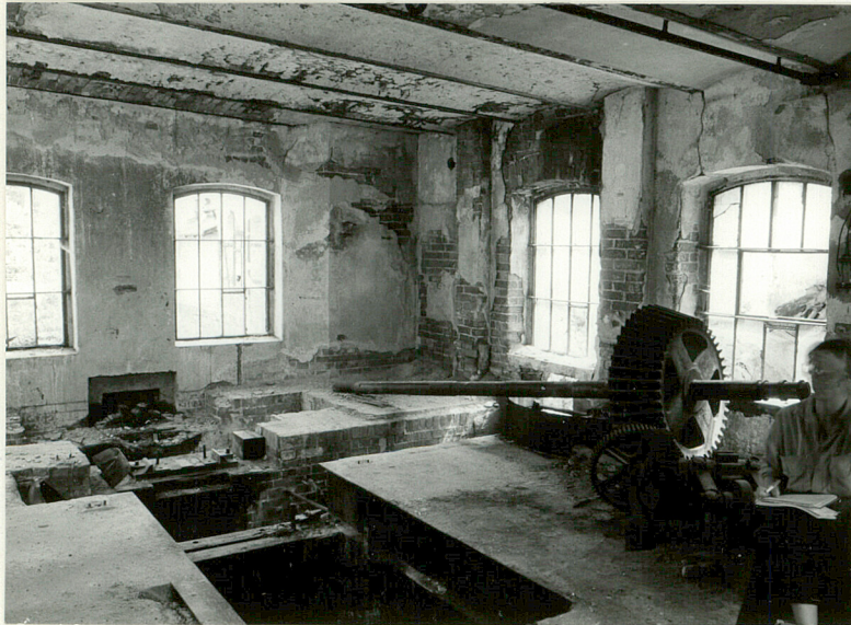
Wnętrze siłowni; widoczny trzon z kołem cywiowym. W podłodze otwór turbiny.
