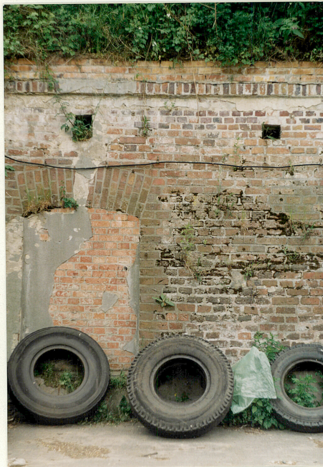
Zamurowany współcześnie otwór doświetlający blok koszarowo- magazynowy. Nad otworem widoczny odpływ wody opadowej ze stropu. Nad nim współczesne powiększenie muru
