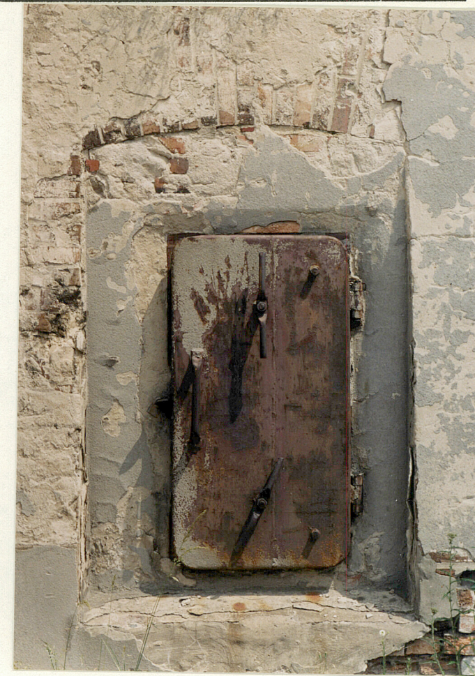
Blok koszarowy fortu miał być wykorz- stany jako schron przeciwlotniczy. Świadczą o tym jeszcze zachowane drzwi stalowe - prawdopodobnie zamon- towane w 1944 r. Drzwi zostały za- montowań w zamurowanym otworze doś- wietlającym.
