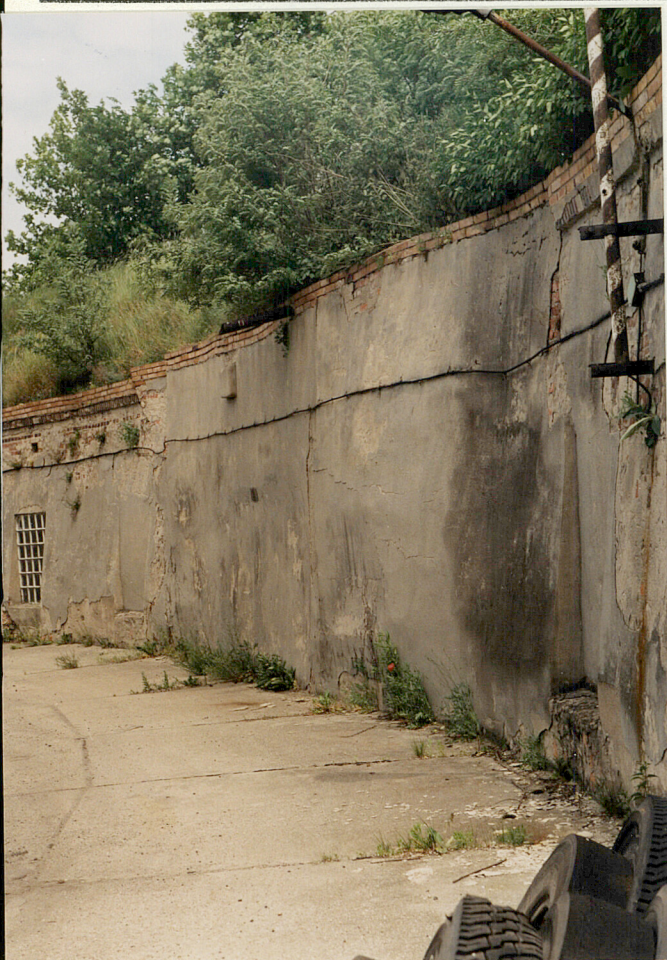
Wybrzuszenie ściany frontowej. Na ścianie widoczna nadrzutka cementowo - wapienna.
