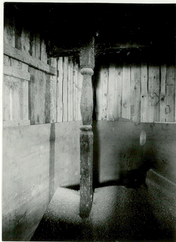
Słupek podtrzymujący strop 2-giej kondygnacji.
