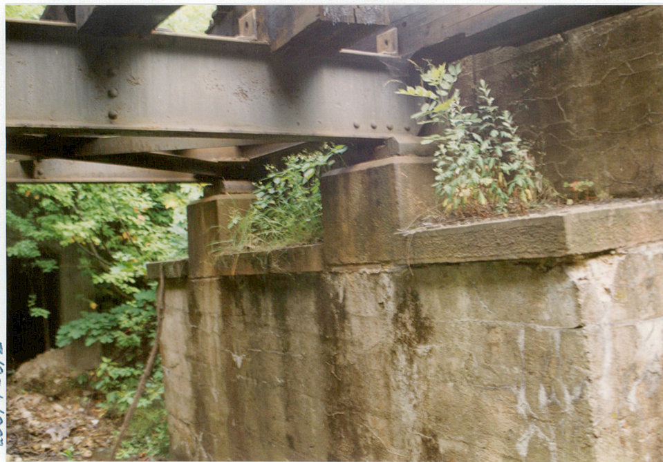
1. Posadowienie blachownicy na przyczółku
