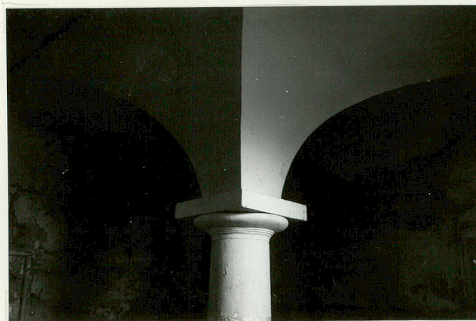
Słup podtrzymujący sklepienie w jednym z pomieszczeń piwnicznych
