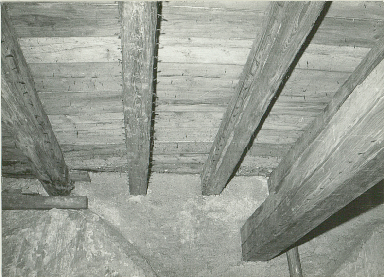
31.Strop dolnej kondygnacji poddasza
