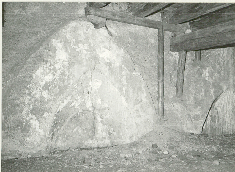
29. Dolna kondygnacja strychu, ściana pn., zamurowane okna nawy, podpory wzma- niające konstrukcję stropu.
