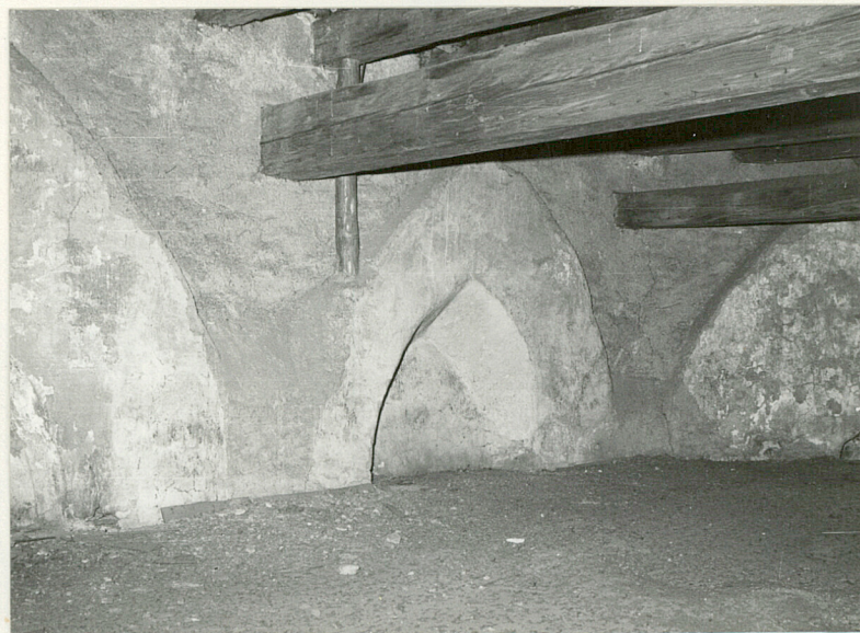
30. Dolna kondygnacja poddasza - zamurowane okna pn.-wsch. części nawy.
