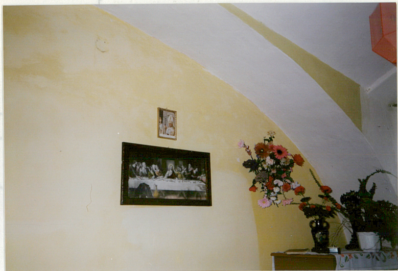
5. Łuk podtrzymujący sklepienie kolebkowe w pomieszczeniu przylegającym do sieni /przęsło wsch./
