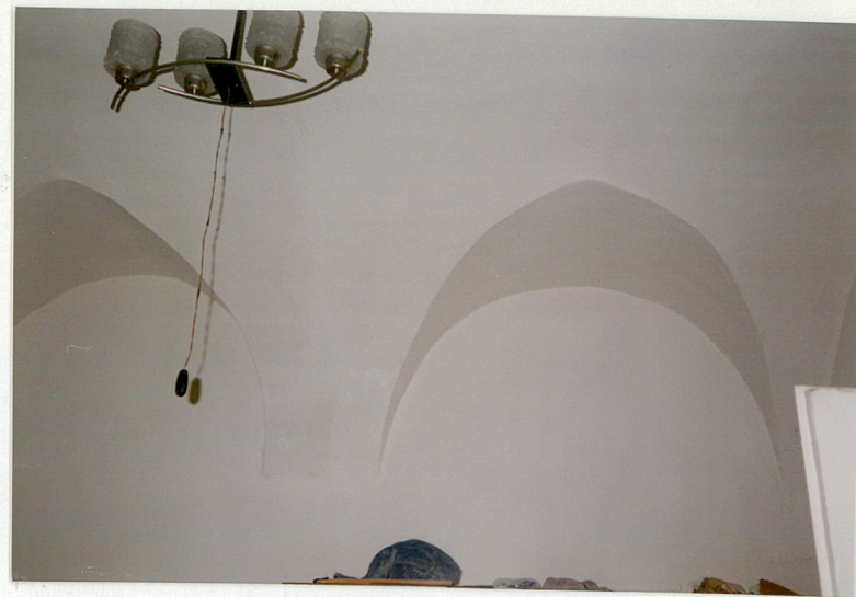
7. Lunety sklepienia kolebkowego w pomieszczeniu środkowym
