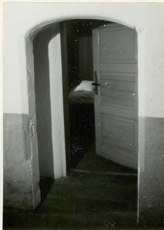
fot.17 obramienie kamienne drzwi we zachodniej wewnętrznej ścianie sieni
