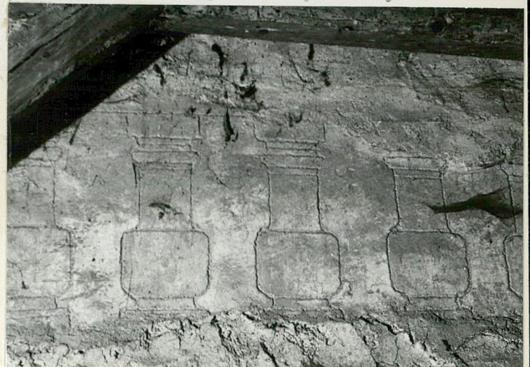
fot.17 sgraffitowa balustrada na ścianie poddasza
