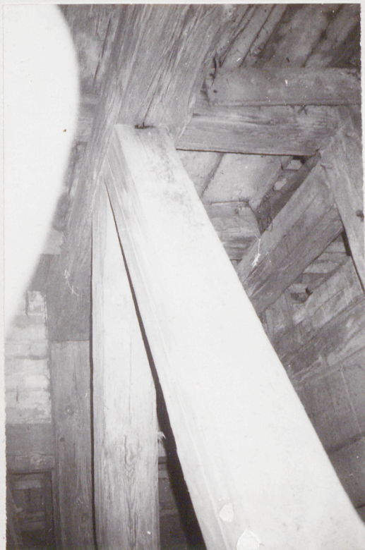
KONSTRUKCJA ZAWIESZENIA DZWONU
