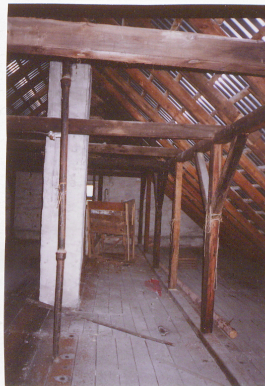
11,12 WIDOK WIEŻBY DACHOWEJ WSPARTEJ NA 2 STOLCACH
