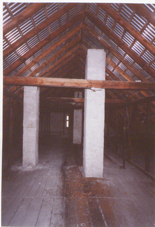
11,12 WIDOK WIEŻBY DACHOWEJ WSPARTEJ NA 2 STOLCACH
