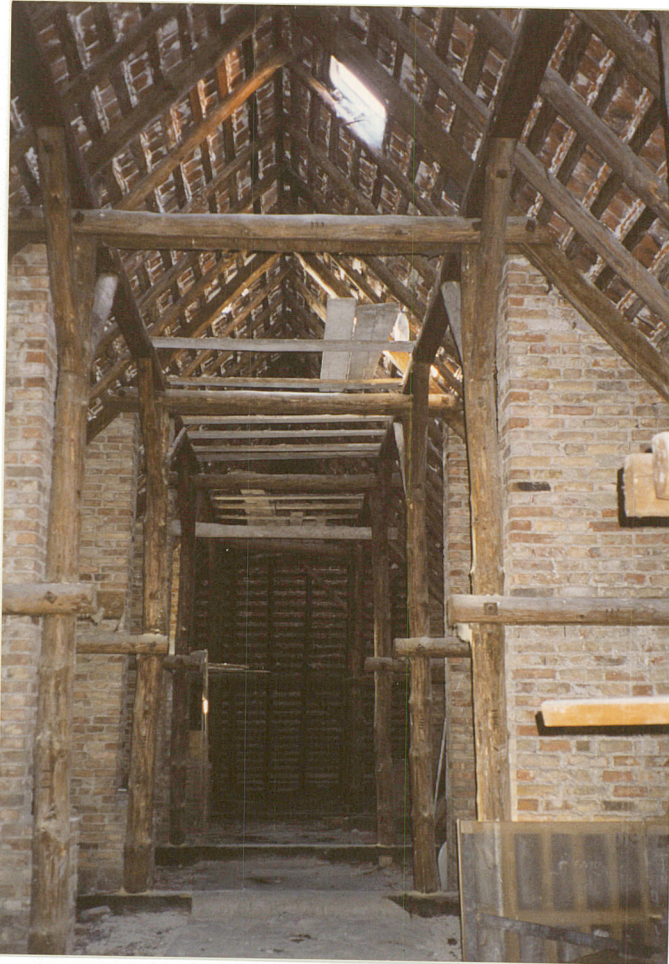
Więźba dachowa nad skrzydłem zachodnim
