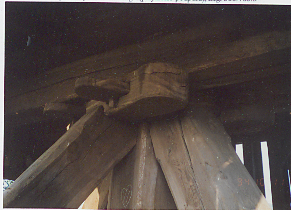
7. Oparcie belek izbicowych - pojazdów na siodle, neg. 300/783/4
