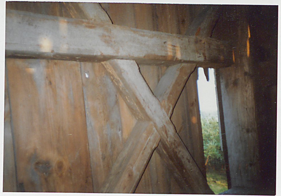
5. Przykład złącza ciesielskiego, neg. 300/787/1
