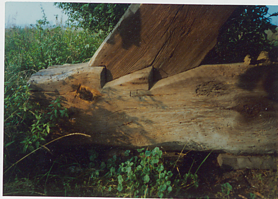
6. Przykład łącza ciesielskiego (przyciesie-podpora), neg. 300/783/3
