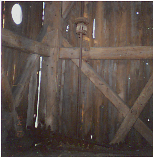
7. Naroże wiatraka, oś napędowa, przenośnik ślimakowy, neg. 300/787/2
