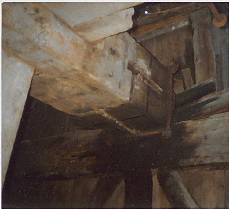
4. Szczegół połączenia wału z głowicą, neg. 300/785/4
