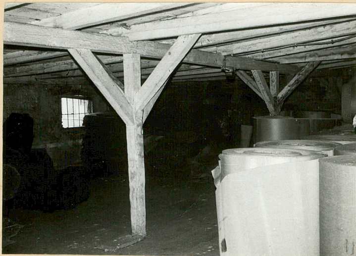
Fot.6 Fragment wieżby dachowej
