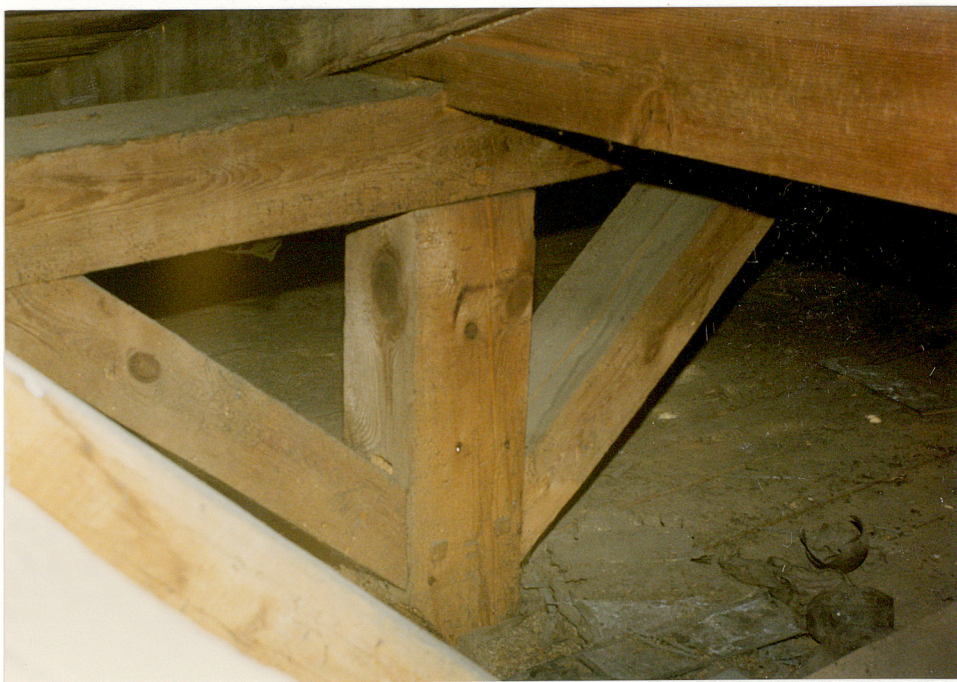
Fragmenty więzby dachowej
