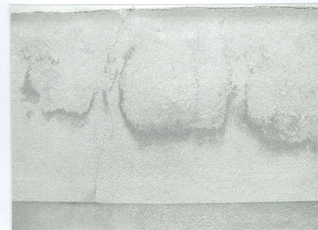
29. Zawilgocenia i spękania tynku w partii przyziemia
