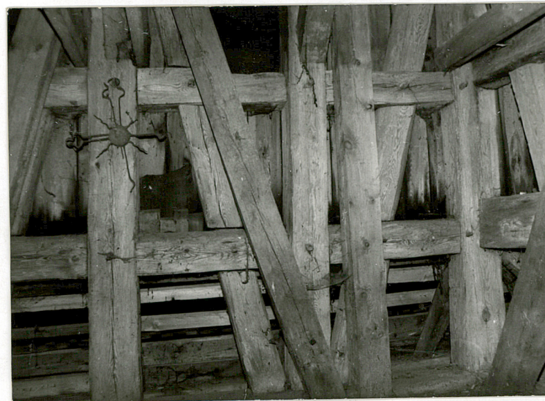
20. Wieża, wewnątrz, konstrukcja ściany
