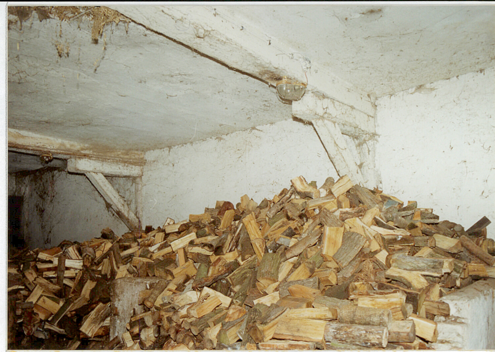
23 Wnętrze chlewni w drugim od pn. prześle → widok na poprzeczną ścianę działową i fragment stropu drewnianego, z podsufitką, o belkach podpartych na dwóch drewnianych podciągach.
