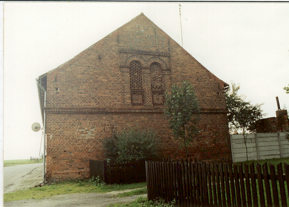
7 Elewacja szczytowa północna: w przyziemiu dwa rodzaje zamurowanych otworów okiennych, a nad gzymsem międzykondygnacyjnym trójkątnie zamknięta strefa szczytu, symetrycznego z datą z główek cegieł zendrówek "1857" i z biforyjnym obramowaniem architektonicznym na osi szczytu, w obramowaniu dwie wysokie blendy o tłach w górnej części pozornie ażurowych, ceglanych, a w dolnej części z pełnymi kwadratowymi niby podokiennikami.
