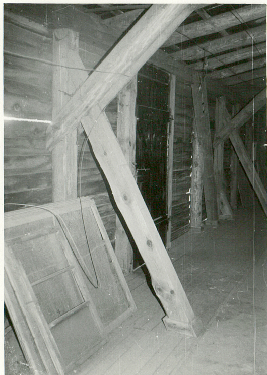
wnętrze stodoły-I kondygnacja frag.konstrukcji nośnej
