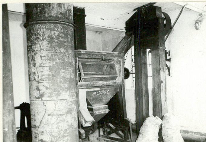
Wietrznik - I kondygnacja płatkarni
