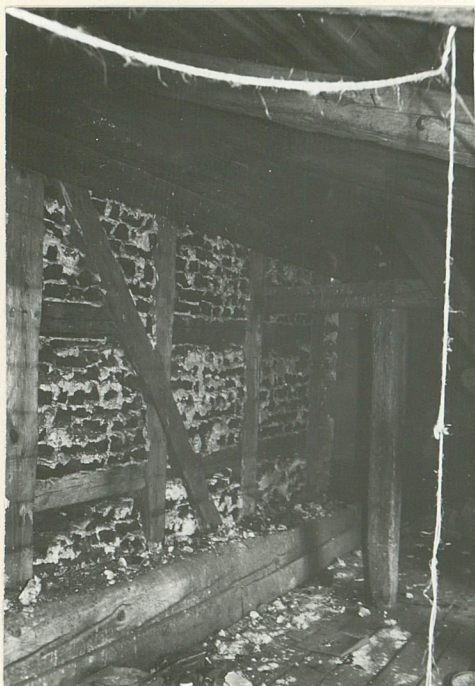
Konstrukcja ściany wewnętrznej na strychu (mur pruski wypełniony torfem)
