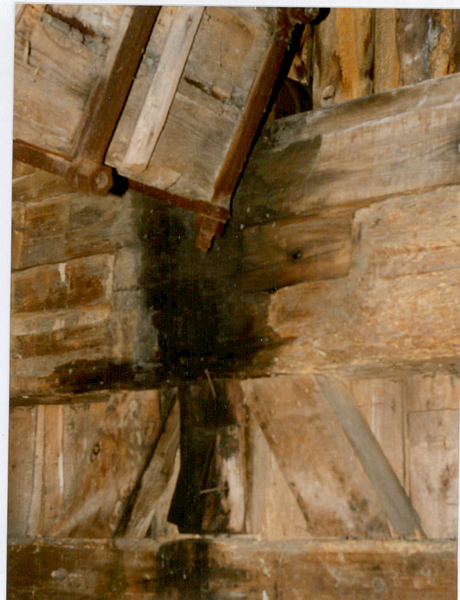
12. Fragment mocowania śmiga w konstrukcji szczytu ściany nawietrznej, neg. 400/162/6
