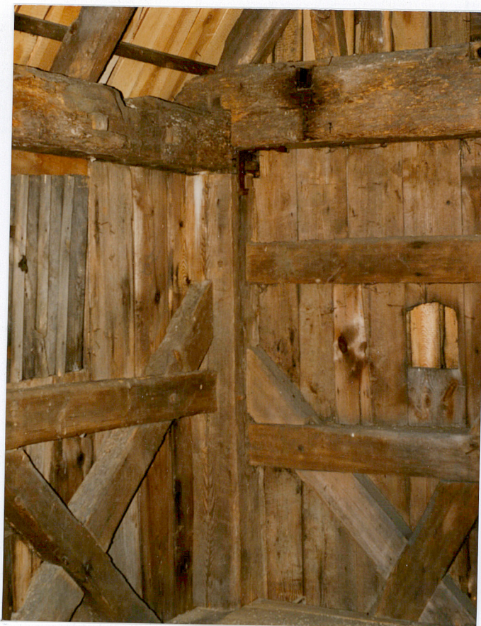
11. Konstrukcja obudowy ścian młyna z połacią dachową, neg. 400/163/1
