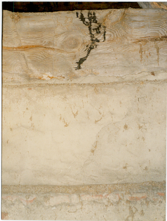
10. Fundament murowany z cegły, tynkowany z belką przyciesia, neg. 400/161/6
