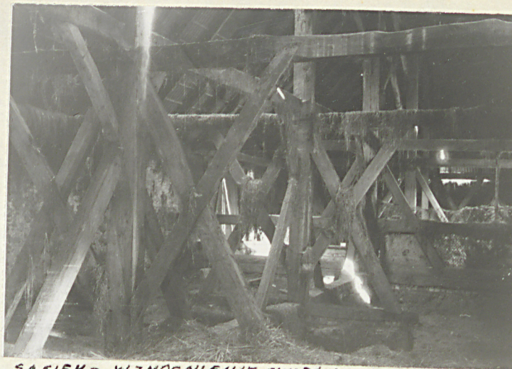
SĄSIEK - WZMOCNIENIE SŁUPÓW
