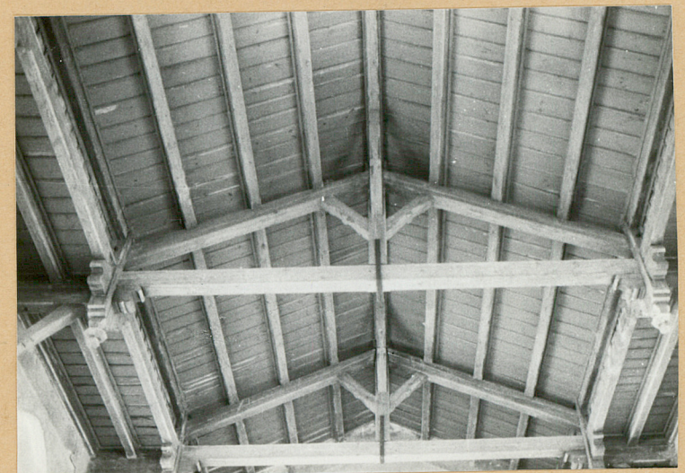
konstrukcja stropu z odkrytą więźbą dachową
