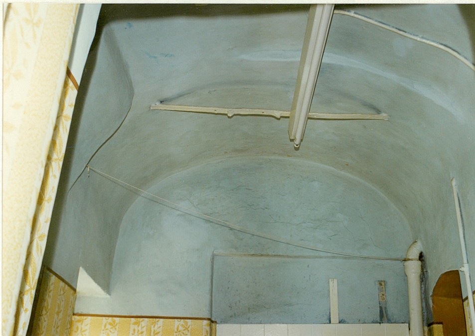
Fot.7. Sklepienie kolebkowe założone na łuku koszowym nakrywające pomieszczenie środkowego traktu na piętrze.
