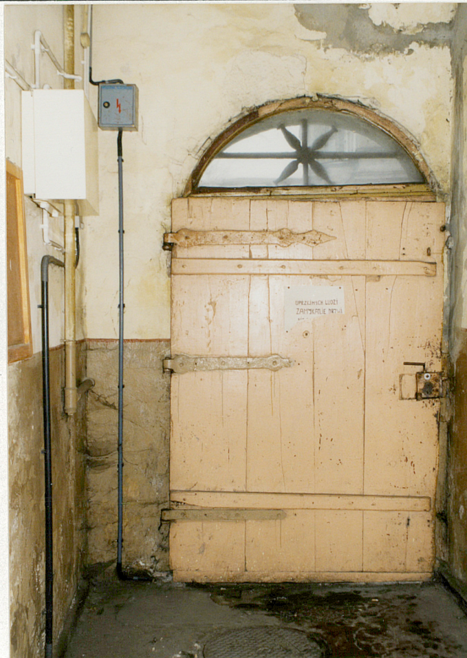
Fot.27. Wnętrze sieni - widok na drzwi wejściowe deskowo-szpungowe.
