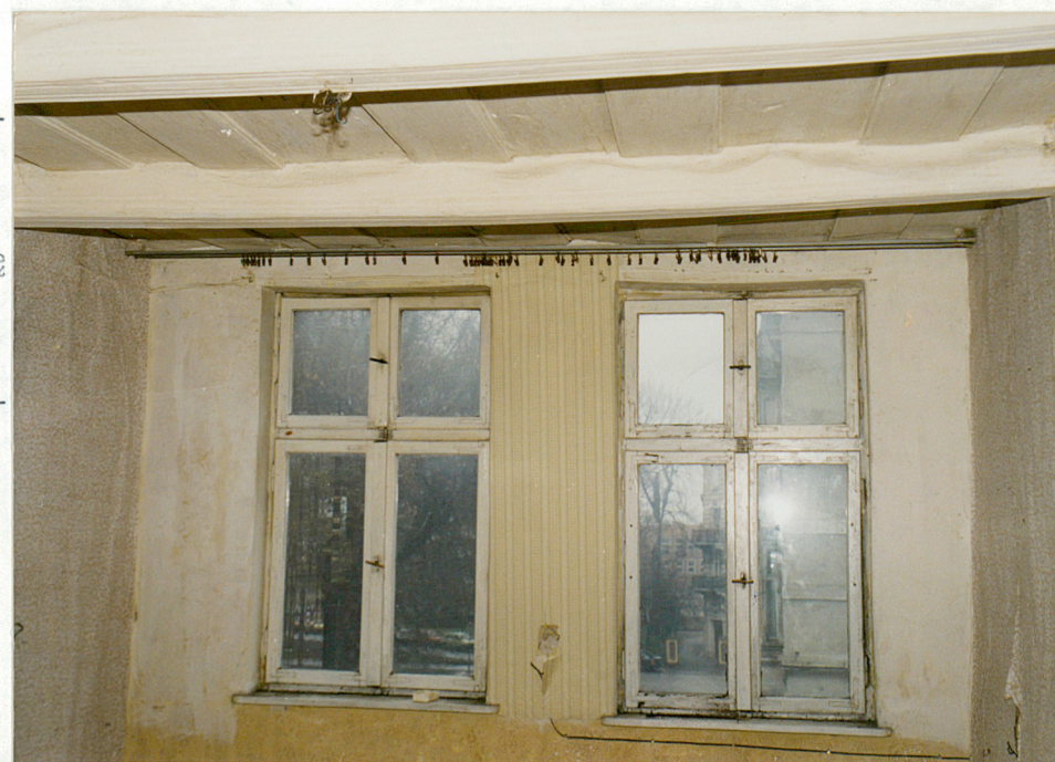
Fot.23. Pokój na poddaszu w trakcie tylnym - ściana z oknem, skrzynkowym, ale z pojedynczymi skrzydłami tylko zewnętrznymi, zawieszonymi na zawiasach kątowych, polskich, na hakach.
