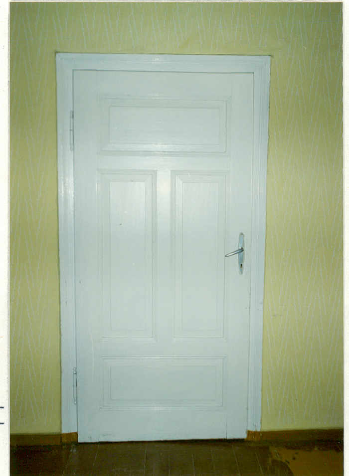
Fot.10. Wnętrze pomieszczenia na piętrze drzwi w traktie przednim – ramowo-płycinowe, z opaskami, (XIX lub I ćw. XX w.).
