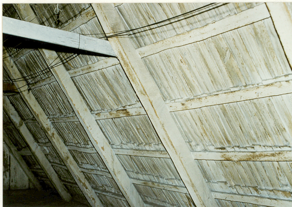
Fot.20. Wnętrze poddasza strychoowego - nad traktem tylnym, czyli w zachodniej części budynku - widok na pokrycie z gontów zachowane w północnej połaci.
