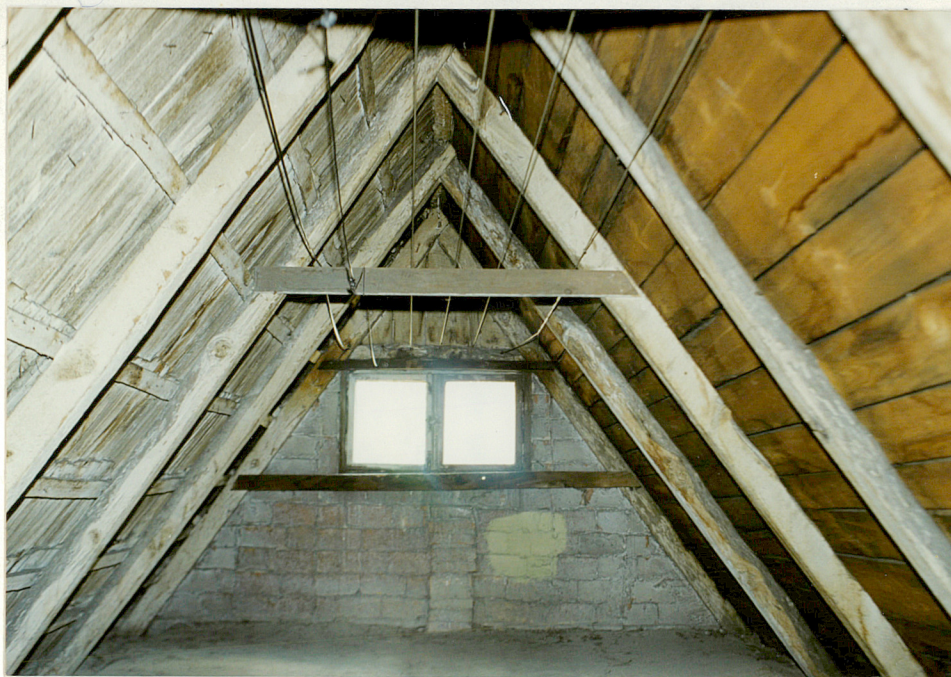
Fot.18. Wnętrze poddasza strychoowego nad traktem przednim - widok w kierunku ściany szczytowej wschodniej; w północnej połaci dachowej zachowane jest oryginalne pokrycie z gontów.
