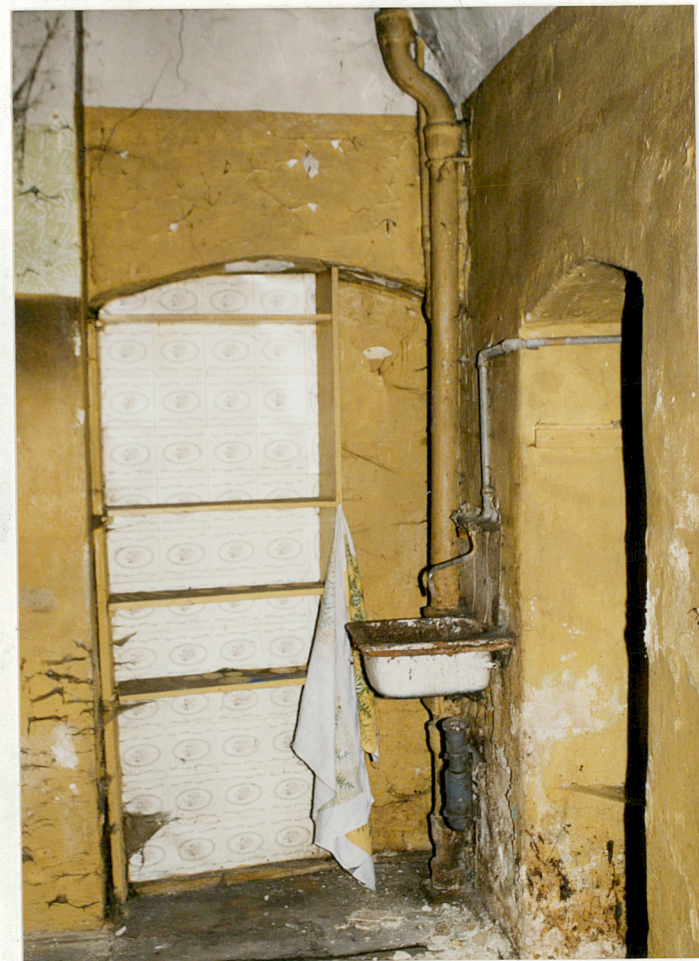
Fot.31. Wnętrze sklepionego pomieszczenia na parterze → widok na zamurowany otwór drzwiowy w ścianie tarczowej zachodniej i szafkę ścienną w ścianie północnej.
