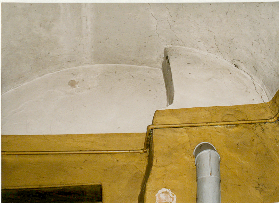
Fot.29. Wnętrze sklepionego pomieszczenia na parterze widok na ścianę tarczową wschodnią, przy której przewód kominowy nieregularnie zwężający się ku górze.
