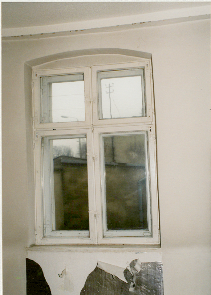
Fot.32. Okno w kondygnacji parteru w trakcie tylnym - podwójne, skrzynkowe, o skrzydłach zawieszonych na zawiasach kątowych,
