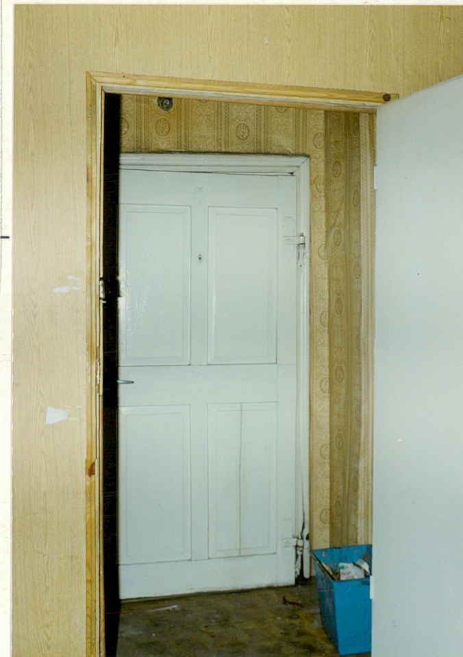
Fot.16. Zawias tarczowy, kuty przy drzwiach ramowo-płycinowych, zamykających przestrzeń poddasza strychowego w bocznej części poddasza.
