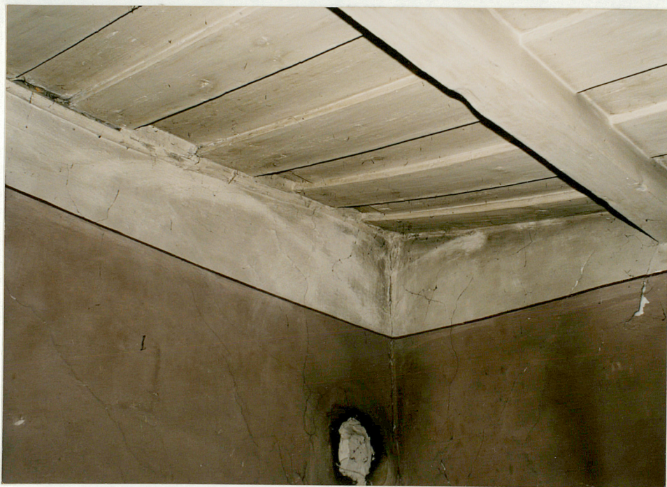
Fot.22. Pokój na poddaszu w trakcie tylnym - to "ugięcie" stropu z pewnością nie powstało samo, lecz było wykonane.
