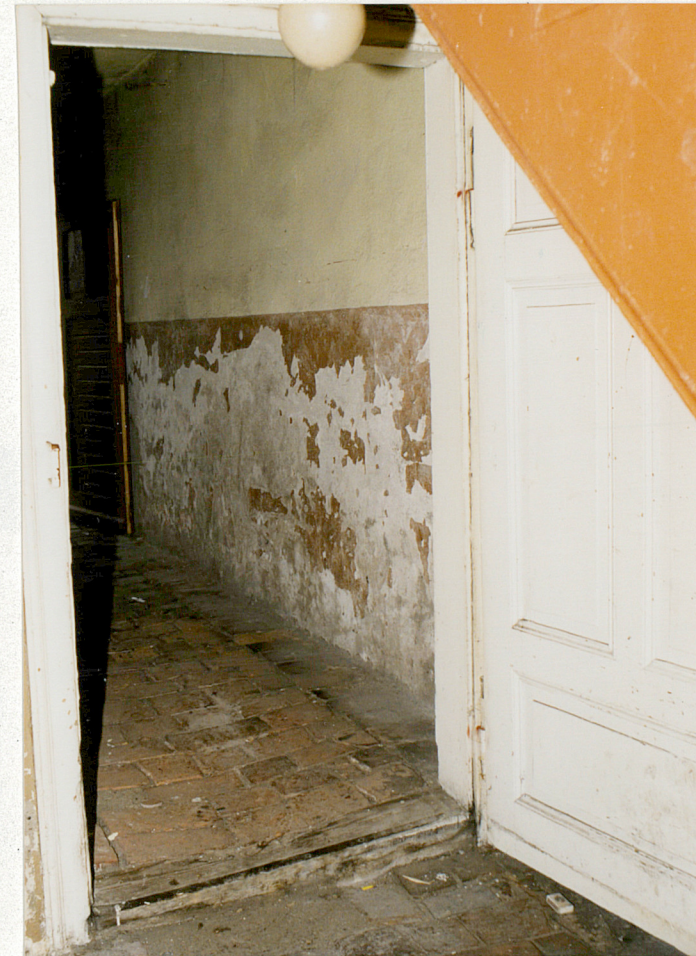
Fot.28. Wnętrze wąskiego korytarza prowadzącego na podwórze - posadzka ceglana.
