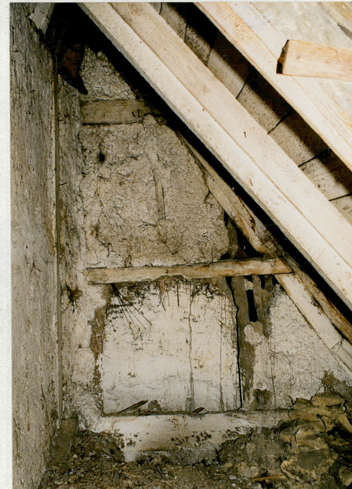
Fot.34. Kondygnacja poddasza boczny strych i widoczna konstrukcja ścian - szachulcowam
