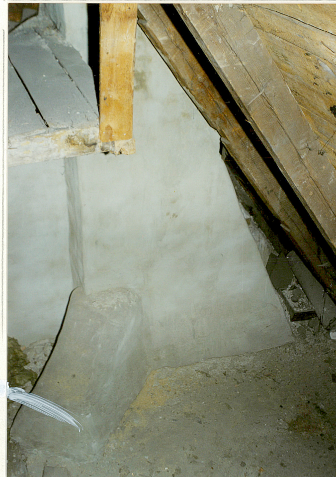
Fot.19. Fragment przewodu kominowego w kondygnacji poddasza strychoowego (przyschodach).
