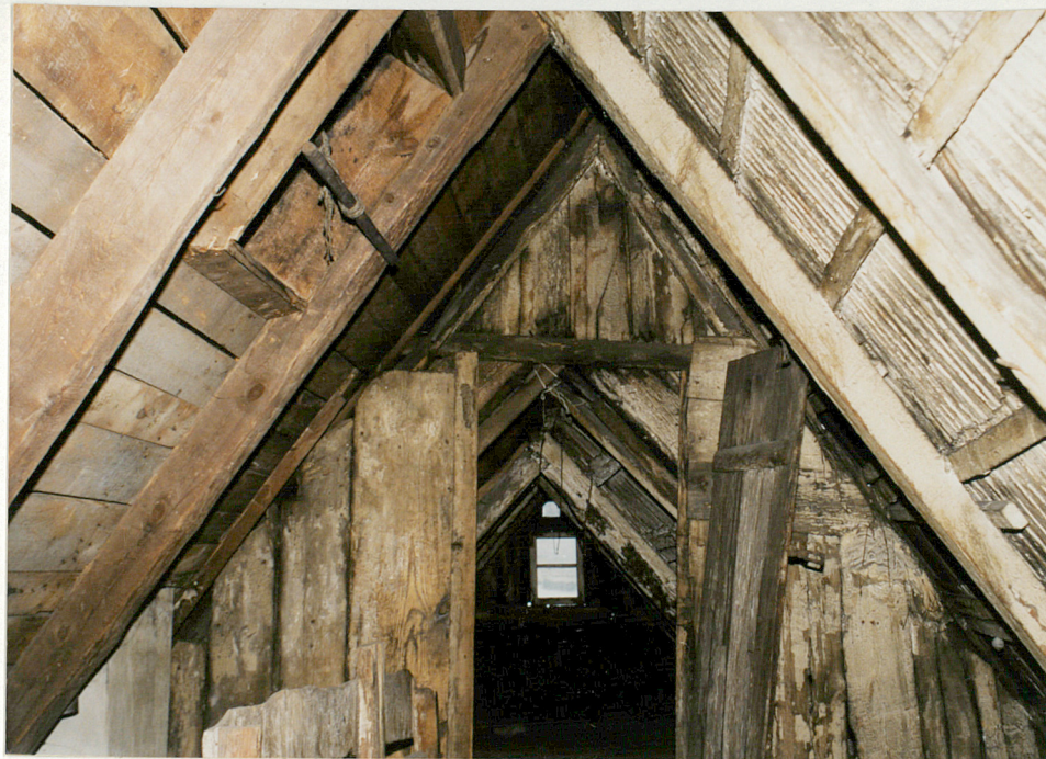
Fot.35. Wnętrze poddasza strychowego – widok z traktu frontowego w kierunku zachodnim – oszalowanie starego szczytu i w głębi jest niższy strych w części od podwórza.
