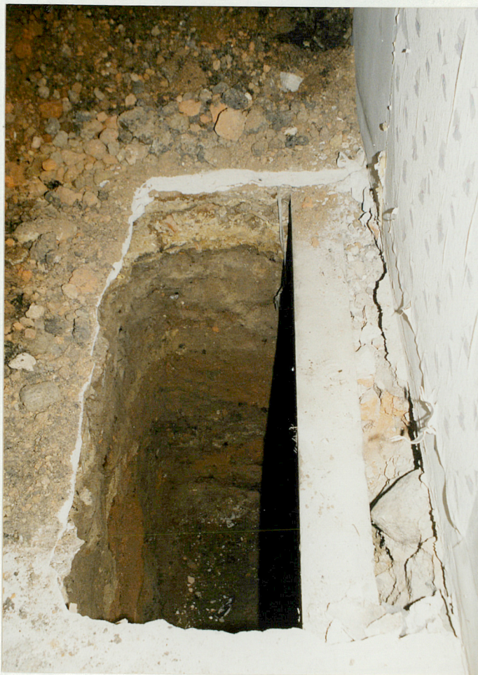
Fot.42. Wykop w pomieszczeniu narożnym południowym w takcie tylnym → widać, że piwnica była sklepiona, nad tym drewniana belka z podłogą i warstwą betonową.
