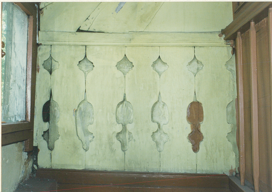
Fot. 11. Fragment oryginalnej barokowej balustrady wokół schodów zachowany nad schodami w kondygnacji poddasza - balustrada o płaskich tralkach wycinanych z szerokich desek (tralaki są tutaj odwrócone).
