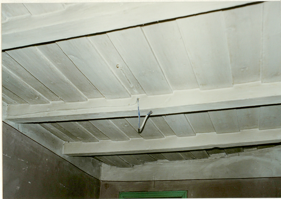
Fot.13. Pomieszczenie w kondygnacji poddasza; strop drewniany, belkowy; belki proste, półap górny z szerokich desek łączonych na tzw. nakładkę polską.
