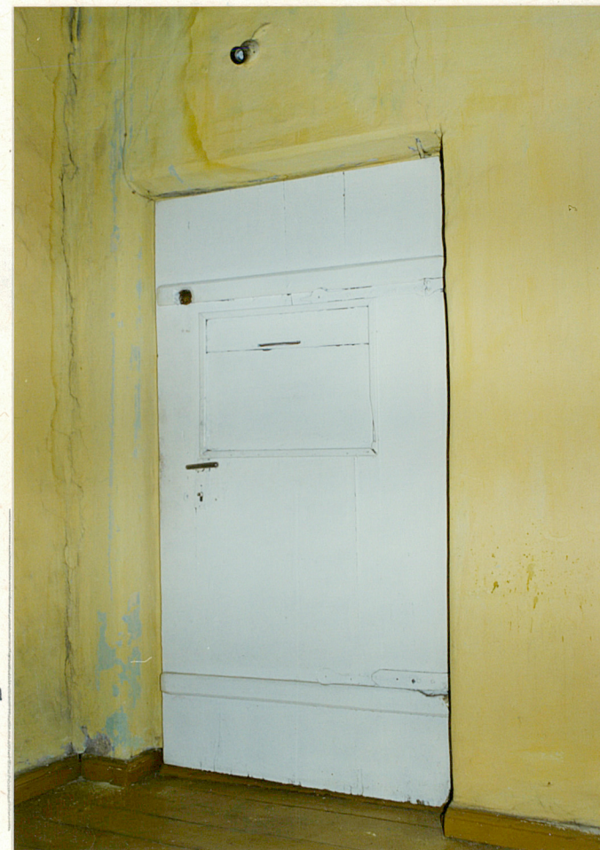
Fot. 12. Drzwi deskowo-szpungowe, zawieszone na kutyh zawiasach polskich (na hakach).
