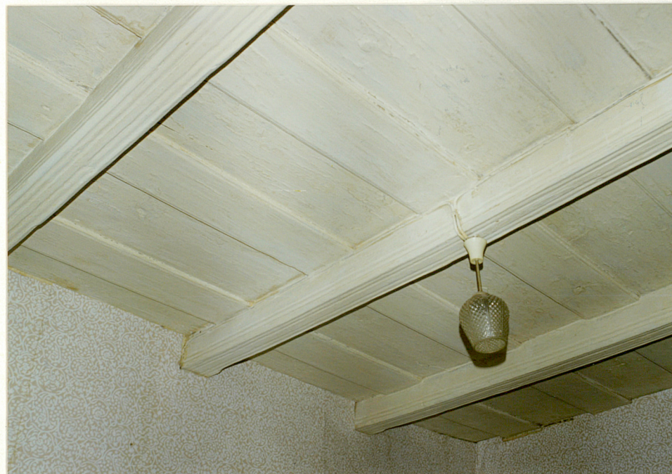
Fot.15. Strop drewniany belkowy; belki o krawędziach sfazowanych i wzdłuż tych krawędzi linearne żłobienia.
