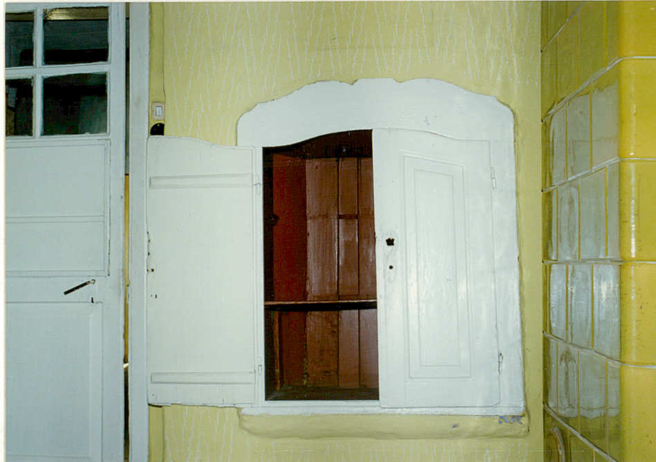
Fot.9. Szafka ścienna, zamykana dwuskrzydłowymi drzwiczkami symetrycznymi konstrukcji deskowo-szpungowej, od zewnątrz opierzanymi w układ ramowo-płycinowy. Szafka otoczona skromnym obramowaniem drewnianym o formach barokowych. (XVIII w.).
