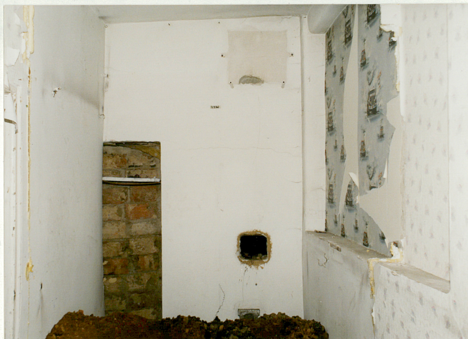
Fot.43. Wnętrze parteru - pomieszczenie skrajne od południa w trakcie tylnym (gdzie jest odkryta piwnica) - widok na ścianę wschodnią, w której połowa zamurowanego otworu drzwiowego prowadzącego do pomieszczenia sklepionego (druga strony tego otworu drzwiowego widoczna jest na fotografii nr 31).
