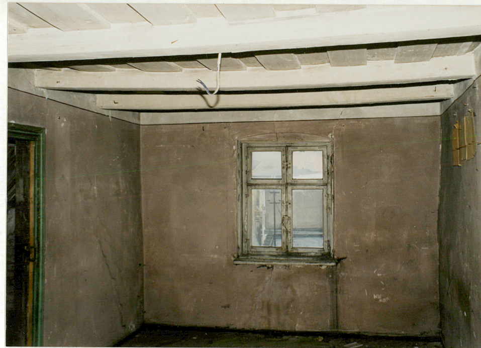
Fot.23. Pokój na poddaszu w trakcie tylnym - ściana z oknem, skrzynkowym, ale z pojedynczymi skrzydłami tylko zewnętrznymi, zawieszonymi na zawiasach kątowych, polskich, na hakach.
