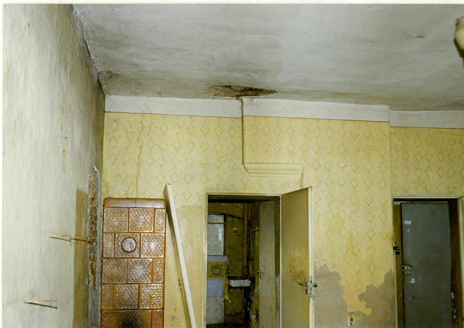
Fot.4. Wnętrze pomiesz- czenia parteru - trakt przed- ni (frontowy) - widok ogólny na ścianę dzia- łową i drzwi do traktu środ- kowego - prze- wód kominowy częściowo nad- wieszony.
