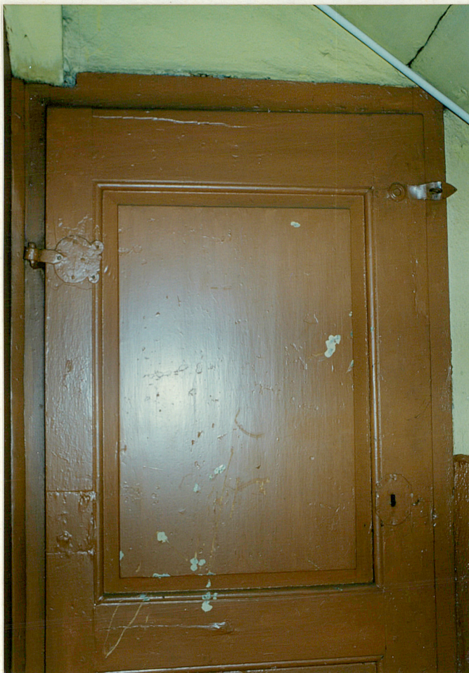
Fot.16. Zawias tarczowy, kuty przy drzwiach ramowo-płycinowych, zamykających przestrzeń poddasza strychowego w bocznej części poddasza.
