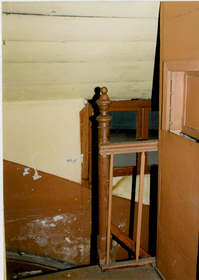
Fot.33. Kondygnacja użytkowego poddasza - końcowy fragment schodów - słupek, prosta balustrada i okno klatki schodowej.
