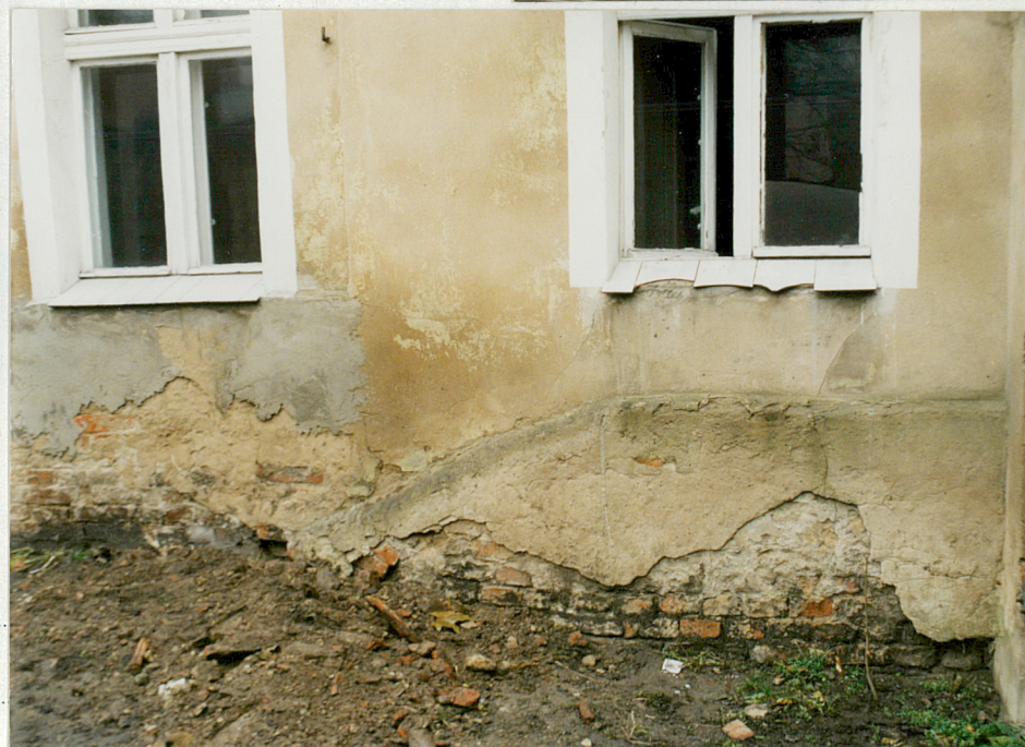
Fot.41. Fragment elewacji tylnej (od podwórza) ślad po dawnej sklepionej piwnicy pierwotnie przylegającej do starego budynku forntowego, nad którą dokonano rozbudowy budynku, (trakt tylny).
