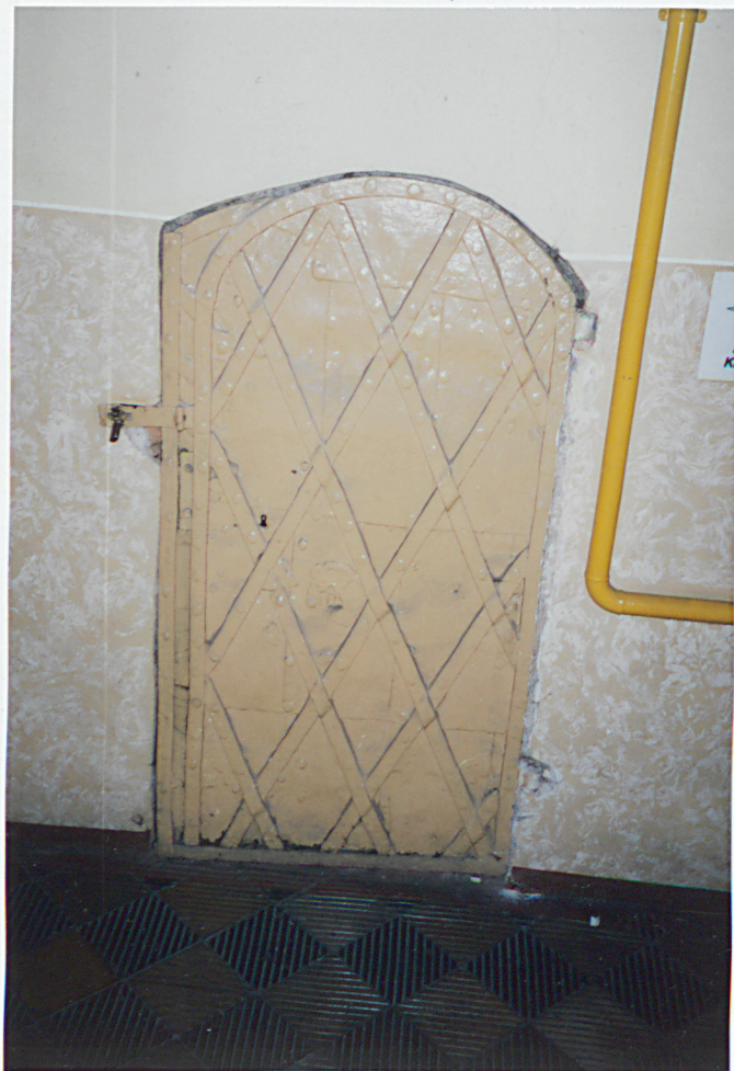
29. drzwi z kutego żelaza w sieni
