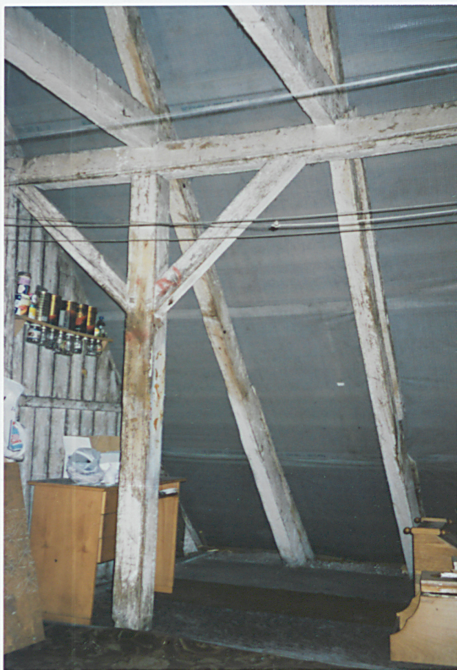
20. płatew i stolec więźby dachowej domu mieszkalnego
