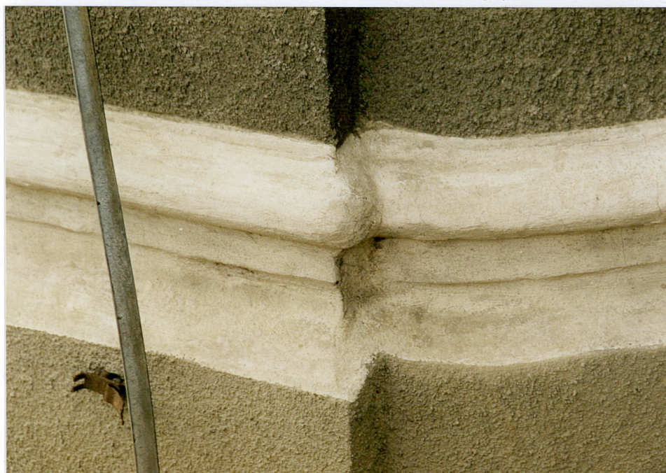
Fot. 3. Strop w pomieszczeniu magazynowym piwnicy. Fot. 5 Profil gzymsu cokołowego.
