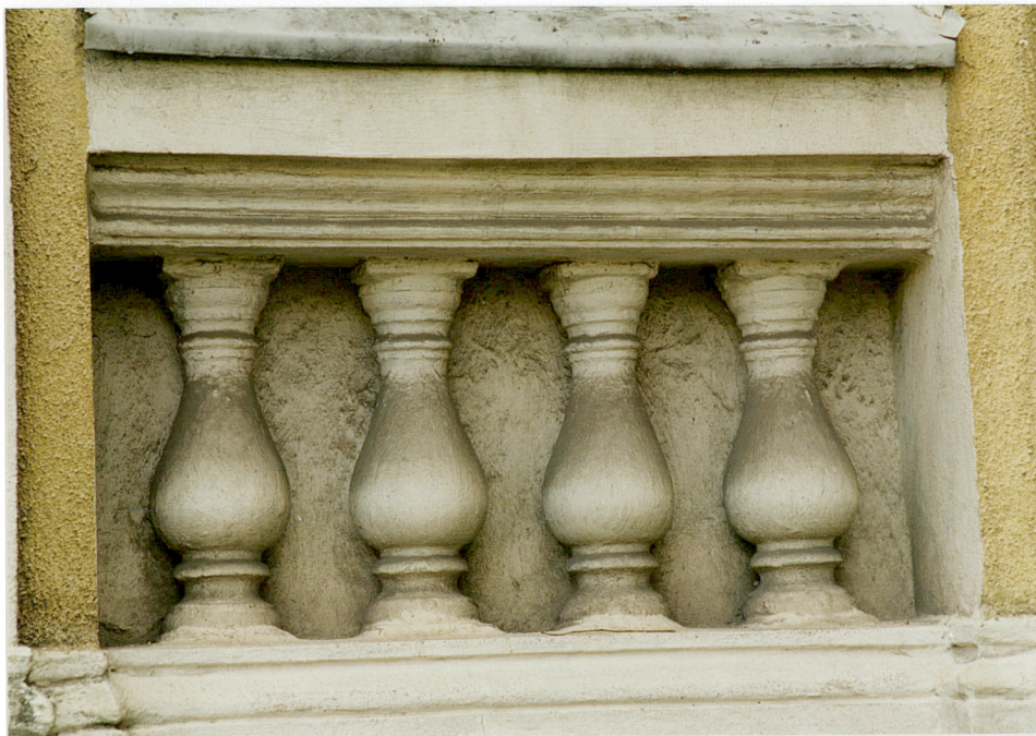
Fot. 30. Tralki w płycinie podokiennej fasady.
