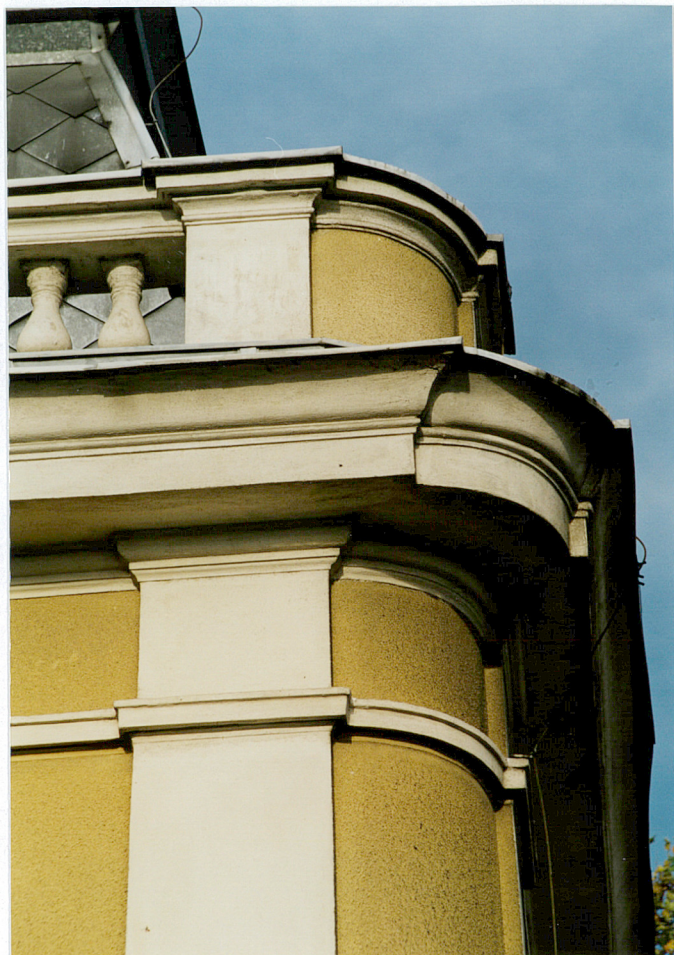
Fot. 31. Profil gzymsu koronującego.
