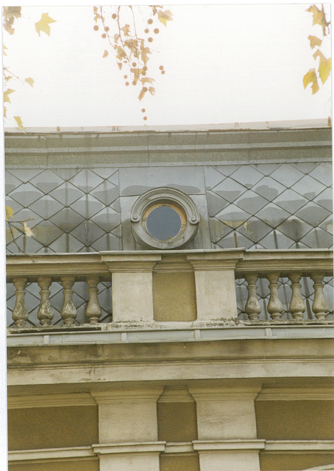
Fot.17.Wółe oko w połaci dachowej.
