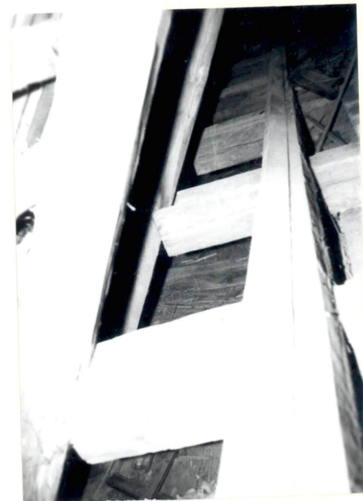
Belki stropowe przechodzące ponad zaskrzynieniem, połączone z krokiewiami.
