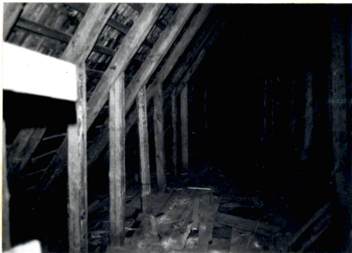
Wieżba dachowa - część północna - rząd słupów podpierających krokwie
