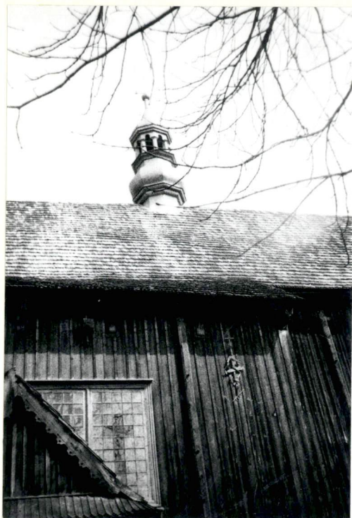
Fragment południowej elewacji - pod linią okapu widoczne zaciępy - oraz sygnaturka
