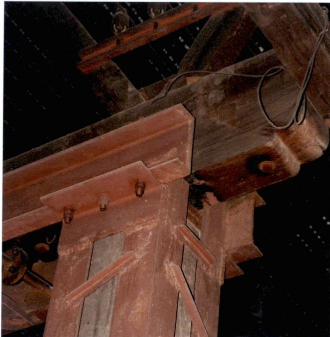
6. Detal ustroju nośnego podpory pod suwnicę, neg. 400/998/32
