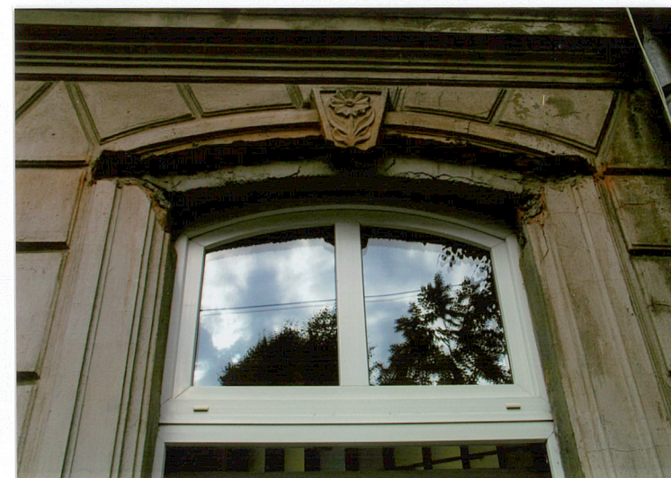
7. Fragment okna 1 kondygnacji, zniszczone nadproża okienne, ul. Ogrodowa 23, Racibórz.
