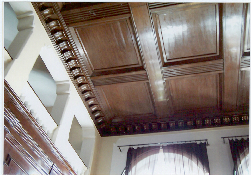
Fot. 37. Sufit kasetonowy, drewniany, w auli.
