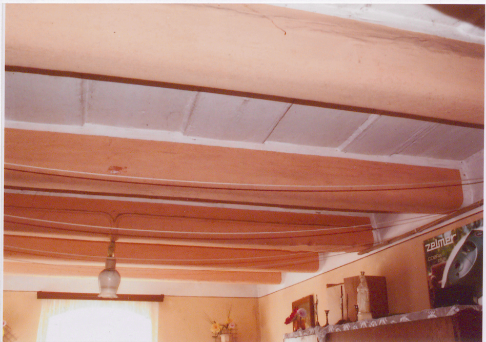
Fot. 14. Drewniany , belkowy strop znajdujący się w pomieszczeniach
