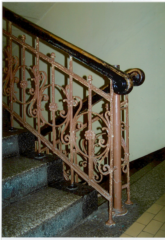
Fot. 23. Detal spocznika ozdobnej balustrady schodów.
