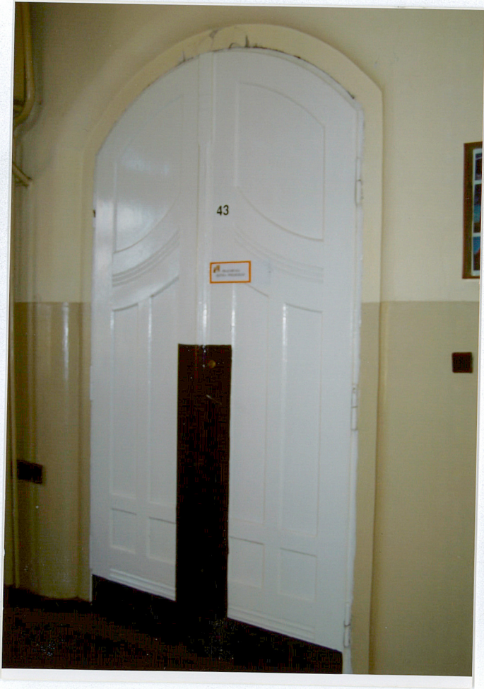
Fot. 28. Dwuskrzydłowe pływające drzwi ostatniej kondygnacji.
