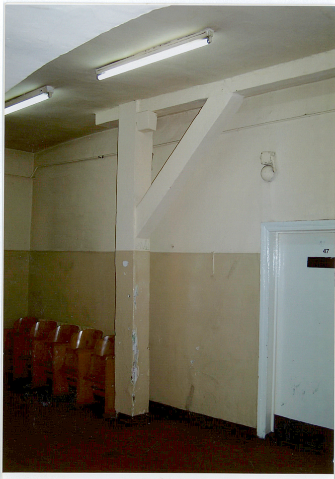
Fot. 32. Konstrukcja więźby dachowej poddasza.
