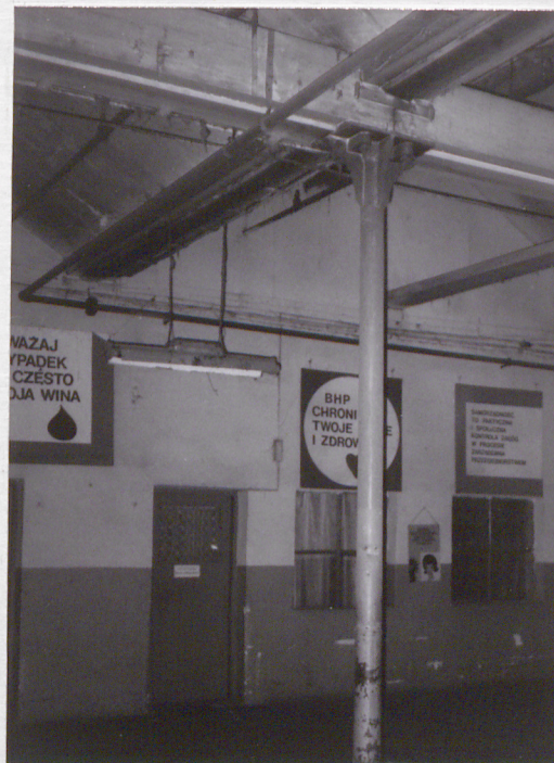
Hała przewijalni - słup żeliwny podtrzymujący konstrukcję dachów szedowych
