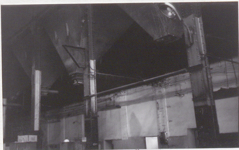
Budynek kotłowni - wewnątrz - metalowe silosy wsparte na konstrukcji podtrzymywanej przez nitowane słupy
