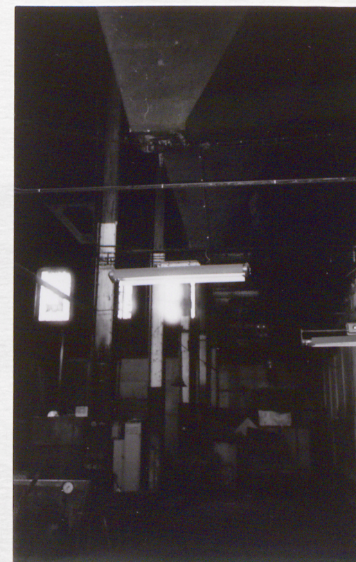
Budynek kotłowni - wnętrze - konstrukcja silosów podtrzymywanych przez nitowane słupy
