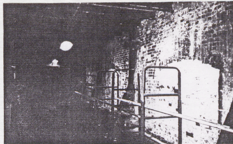
Budynek kotłowni - kondygnacja podziemna pełniąca pierwotnie funkcję tzw. „popielnika”
