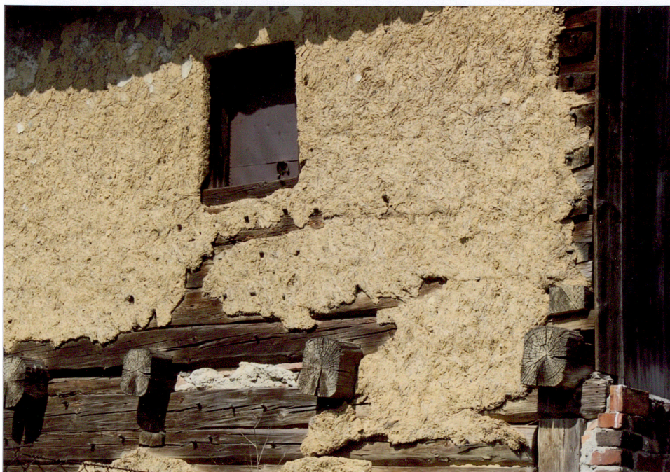
9. Pozostałości glinowej obrzutki na południowo-wschodniej ścianie.
