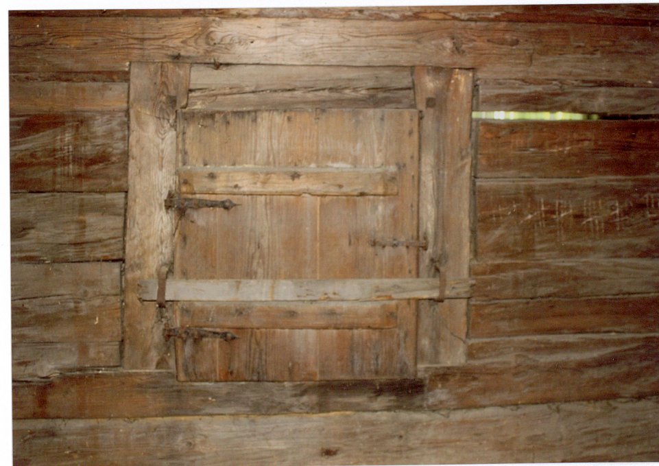
21. Konstrukcja okna.
